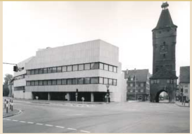
Neubau der Hauptstelle in Biberach 1974
